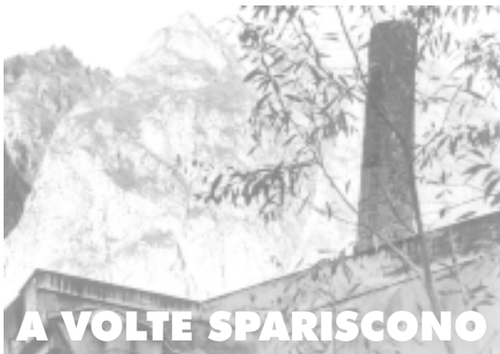
A VOLTE SPARISCONO Boario Terme: la ciminiera del vecchio cotonificio Olcese, demolita, nonostante un veto regionale, per far posto ad altri "interessi". Un altro pezzo di storia che se ne va... foto di Giovanni Luna (dalla Mostra dell'Università Popolare)
